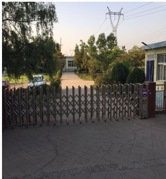
项目厂区大门
