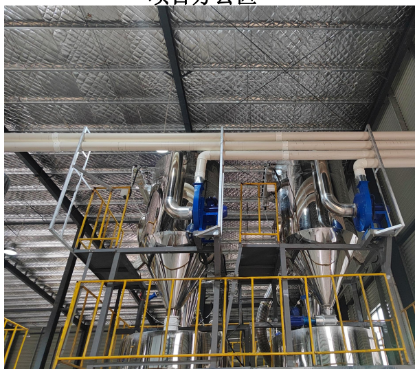
项目生产车间
