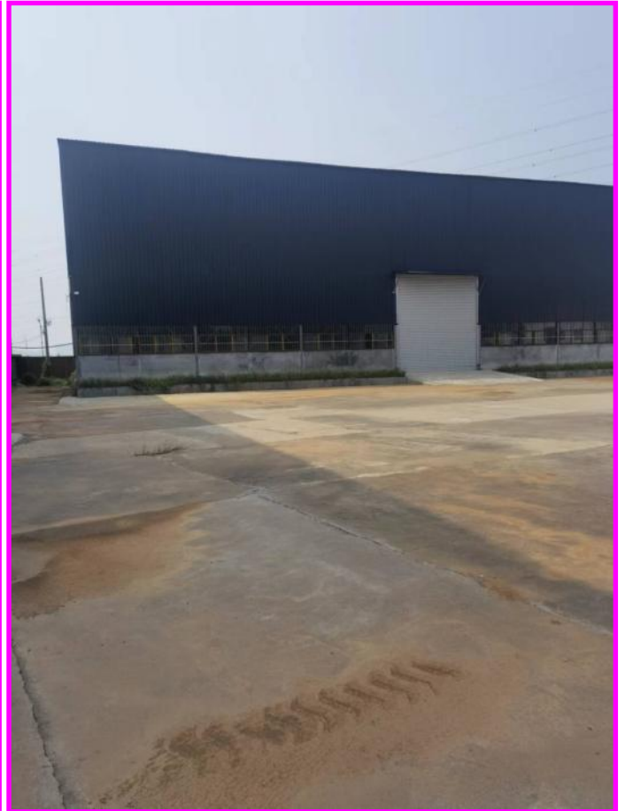
项目西侧厂区道路
