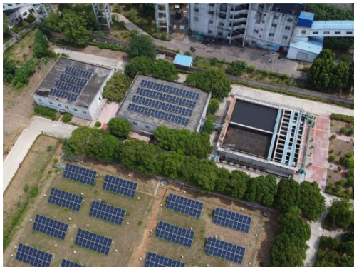
厂区北侧五矿及现有工程斜板沉淀池、F滤池
