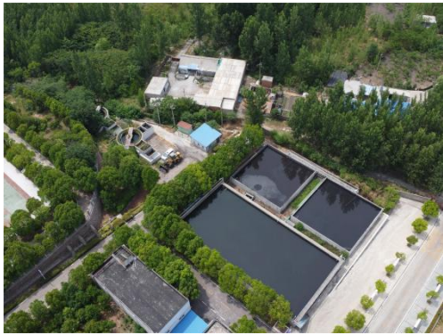
厂区南侧散居居民及依托预沉调节池、排泥池、排水池
