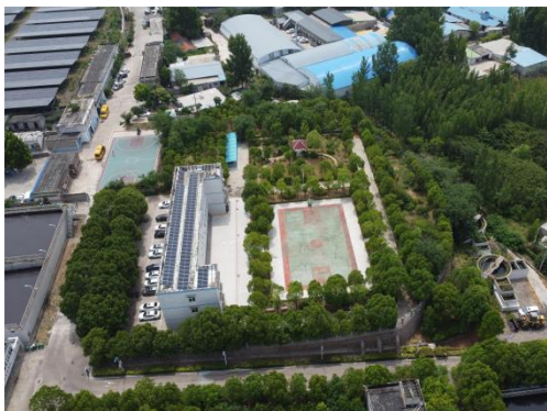
厂区内现有办公楼
